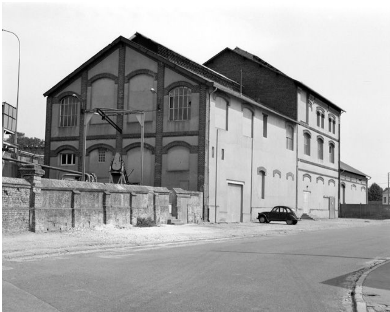
Râperie, flanc sud-ouest.
