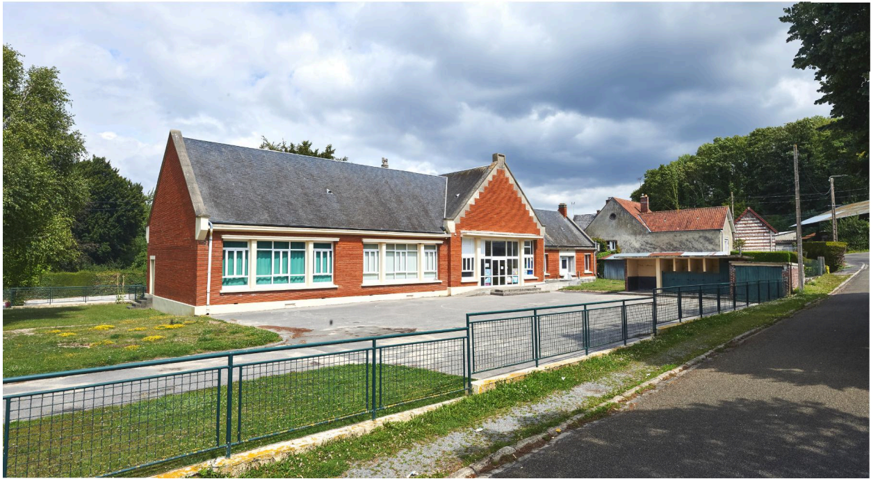
Vue d'ensemble de l'école depuis le sud-ouest.
