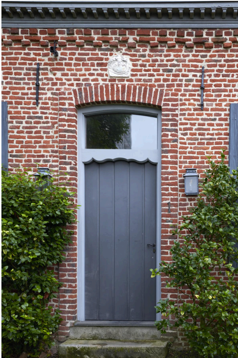
Détail de la porte d'entrée et du blason buché.
