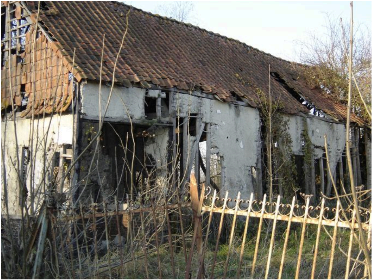
Vue de l'annexe depuis la cour.
