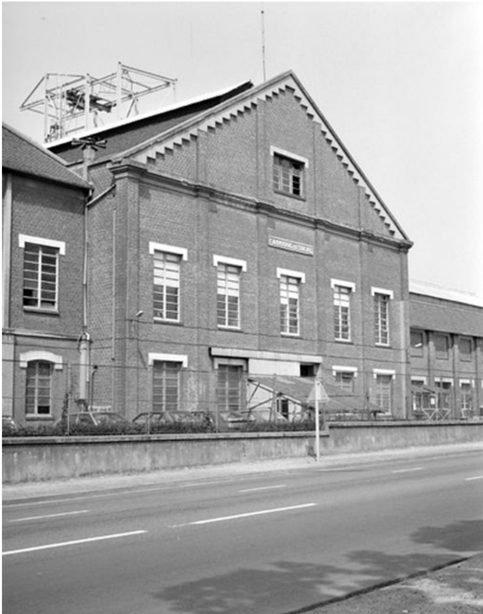
Atelier de fabrication, vue partielle, flanc est.
