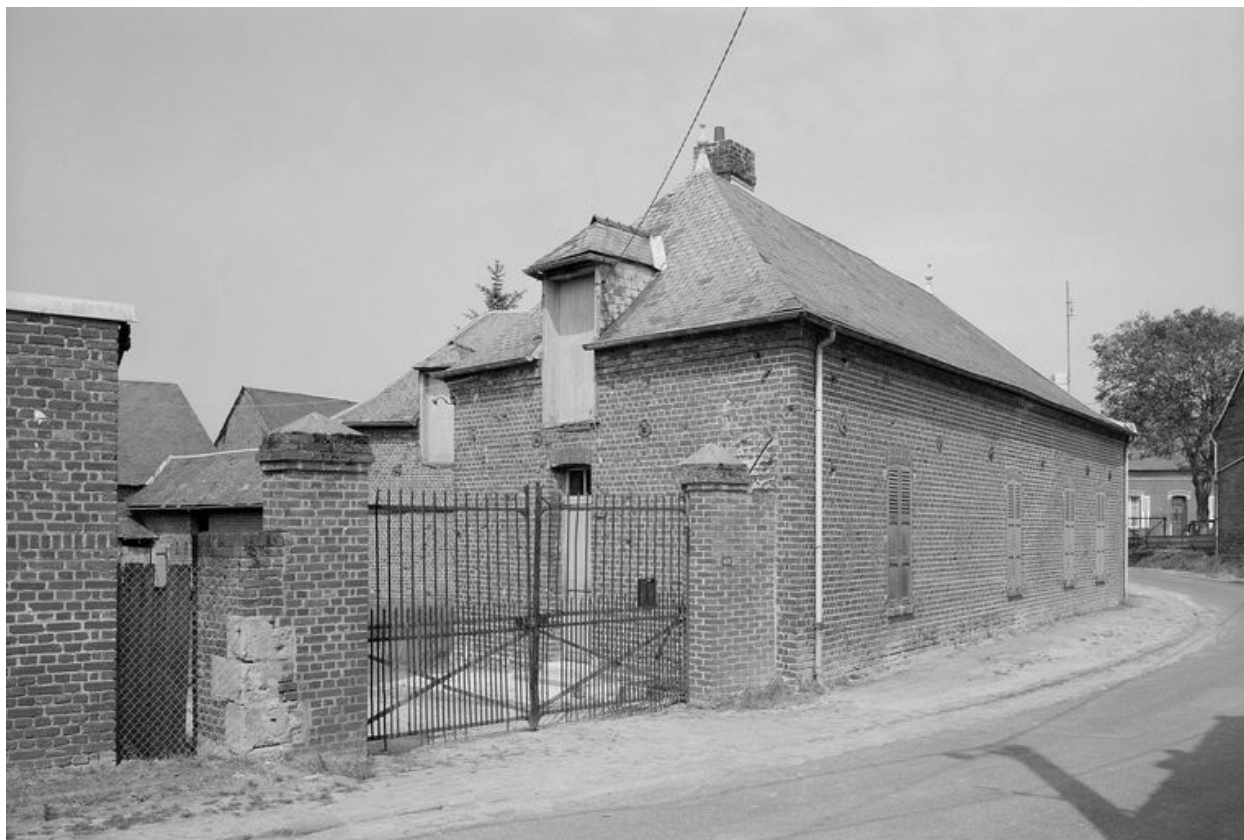
Logis. Elévation sur rue.
