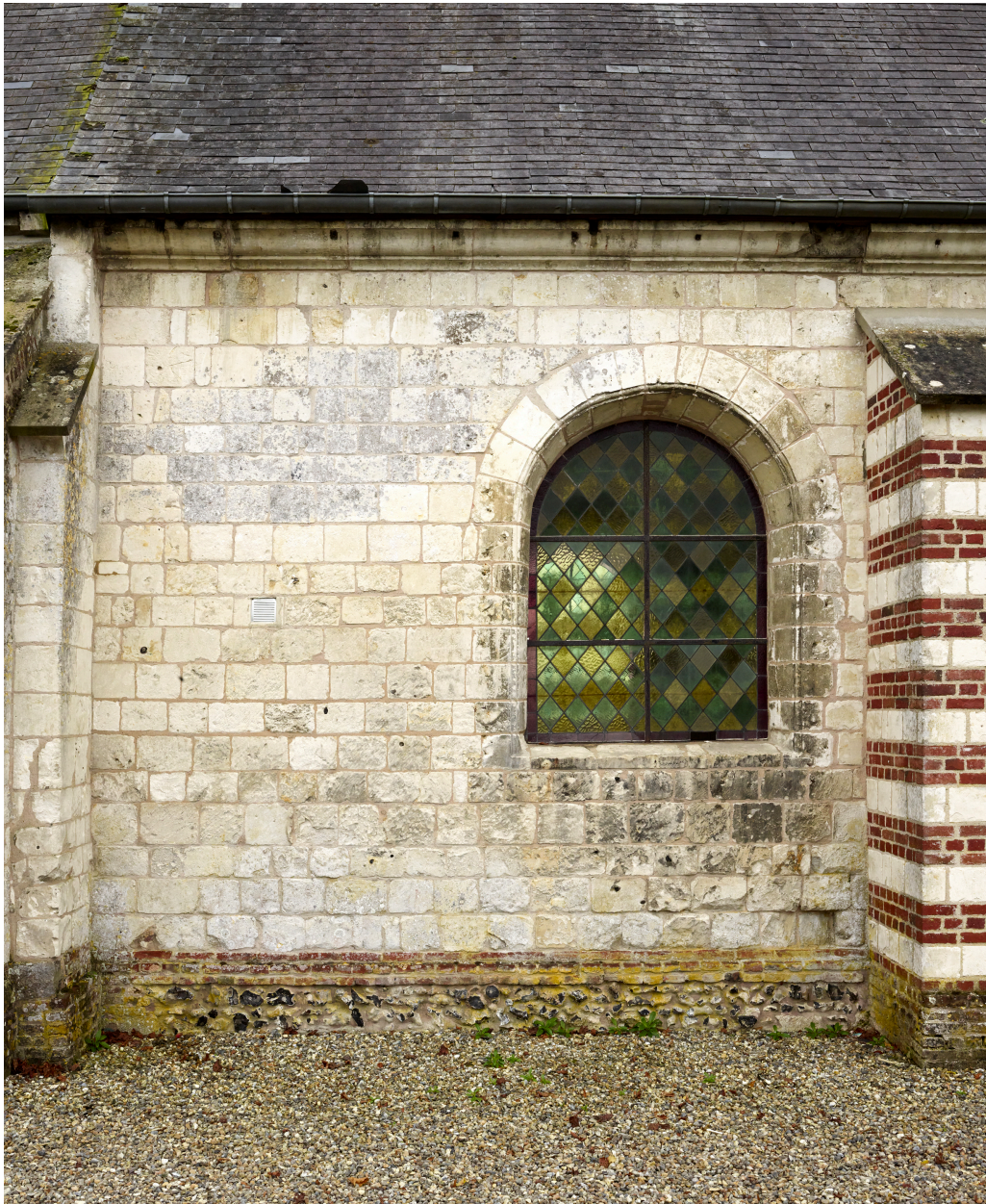
Détail d'une travée de l'élévation nord de la nef.
