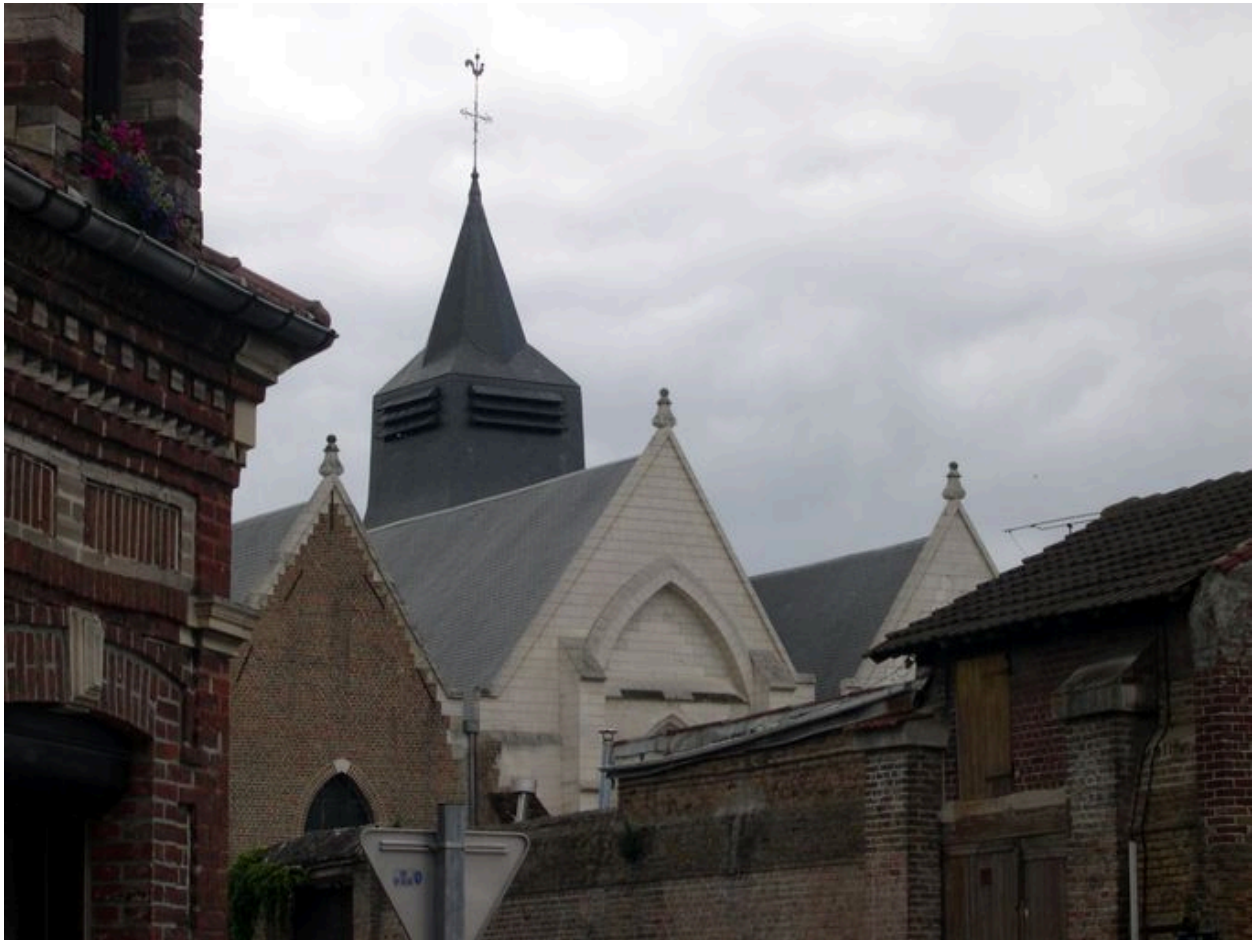
Vue de situation depuis le nord.
