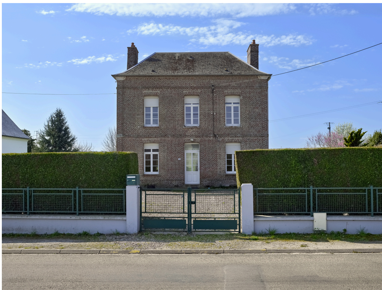
Vue nord du presbytère, depuis la route.
