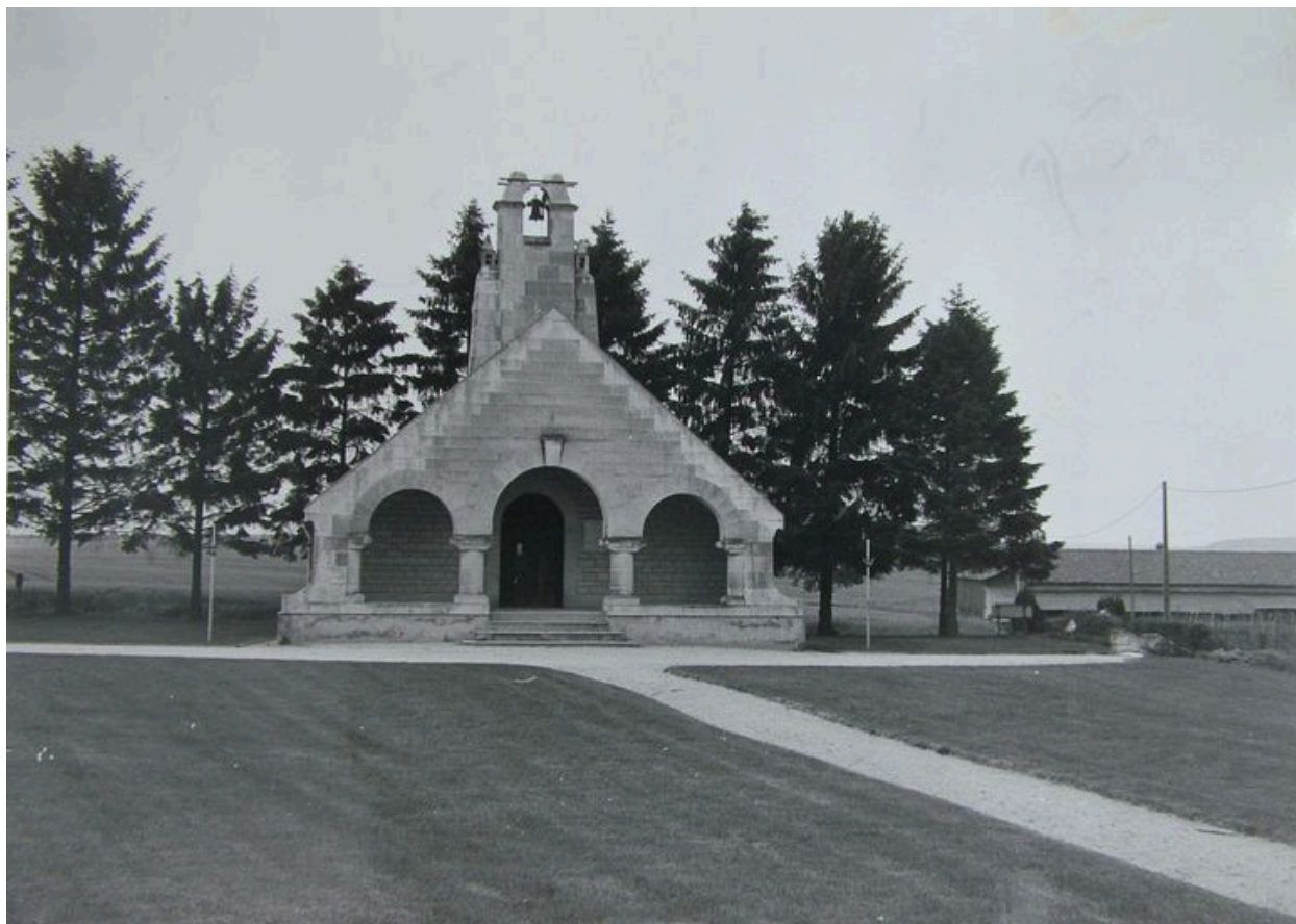
Vue de la chapelle lors de la construction (coll. part).
