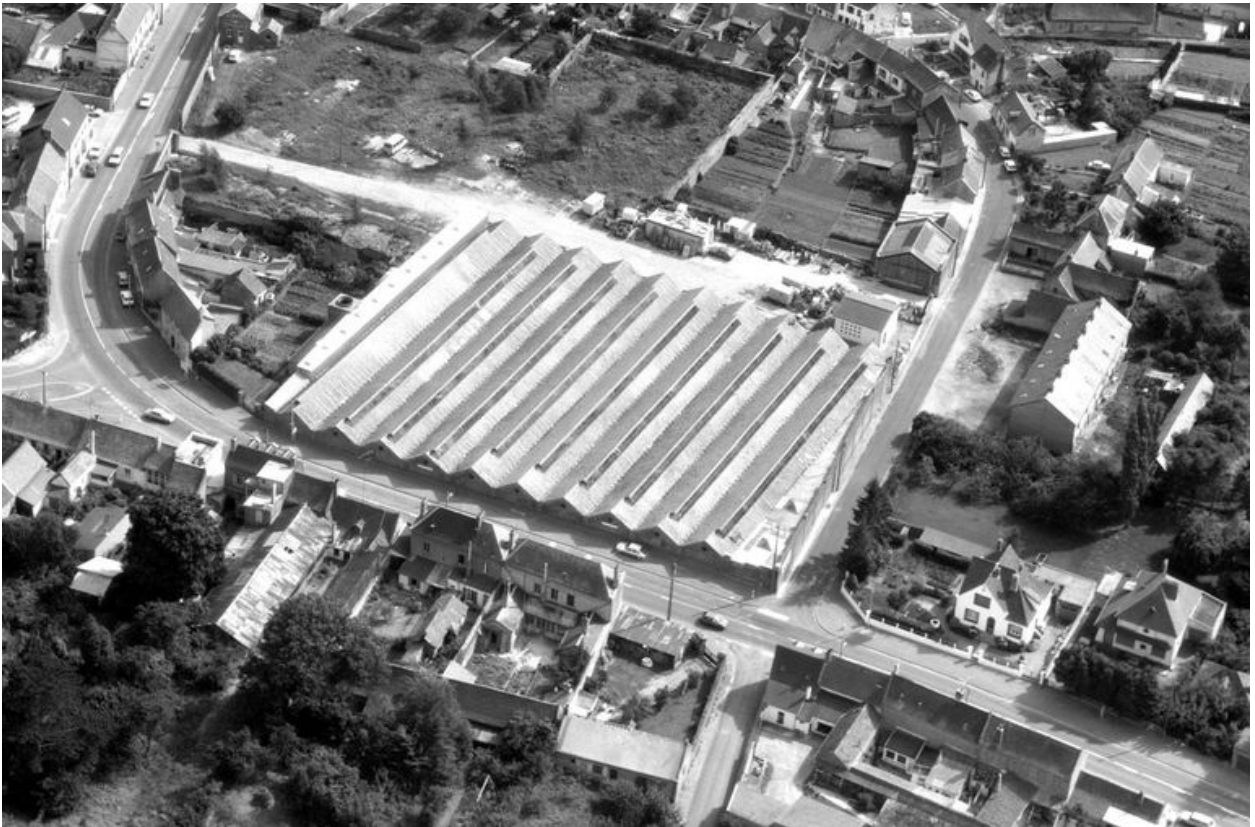
Vue aérienne, flanc est.
