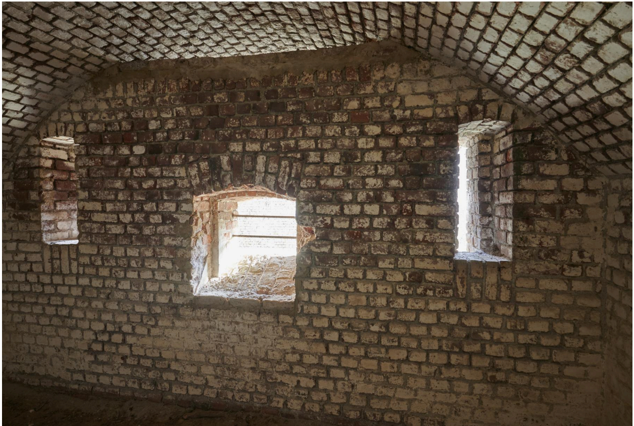
Caponnière double. Embrasures de tir dans le mur de masque.
