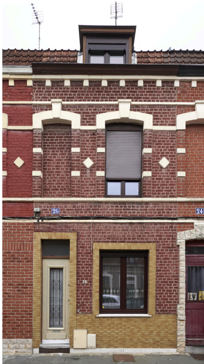
Vue générale du n°26, briques et losanges sur la longueur de sa façade.
