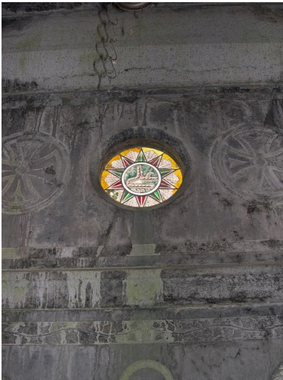
Vue de détail sur le vitrail.
