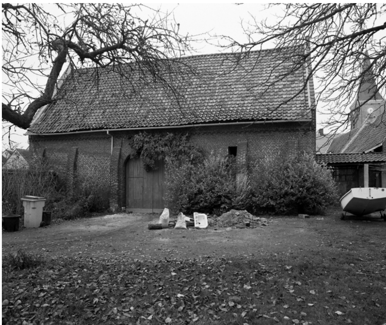
Elévation postérieure de la grange.
