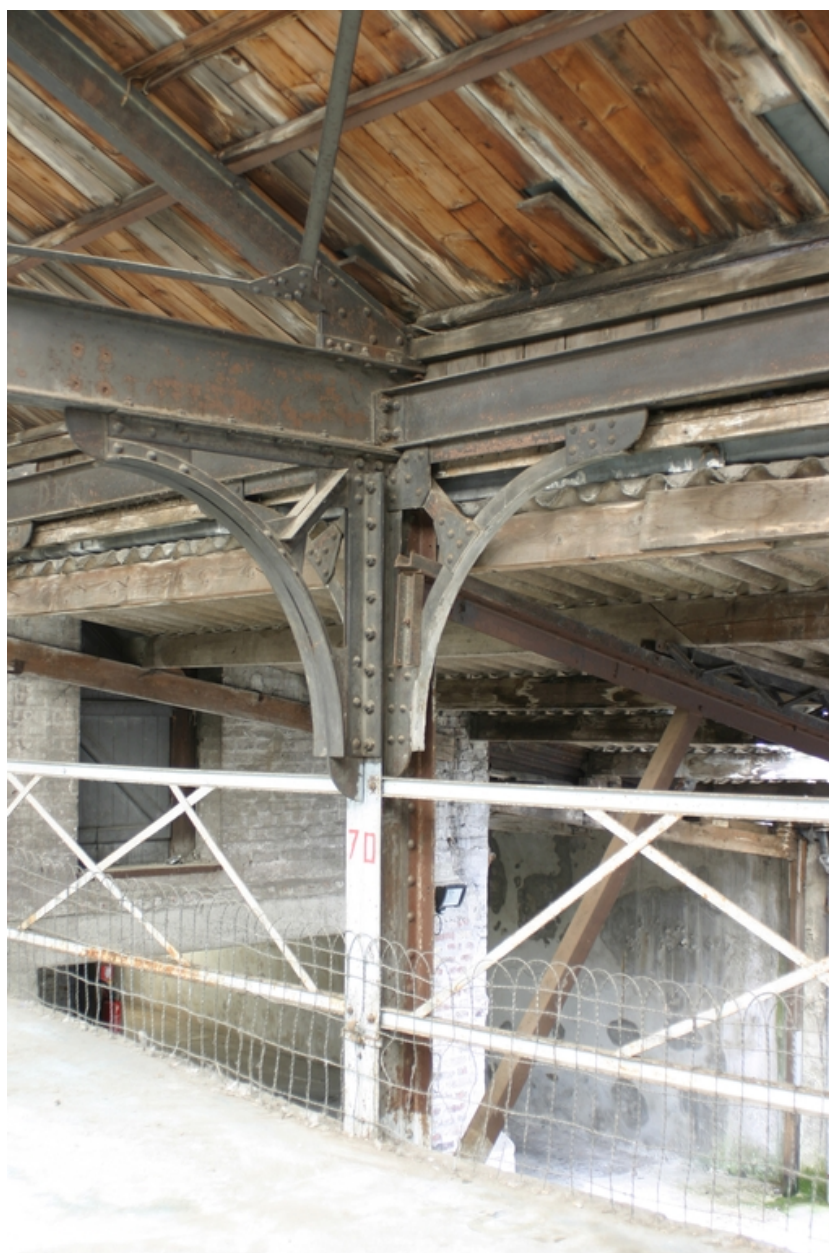
Ancien atelier d'usinage : détail du système constructif.
