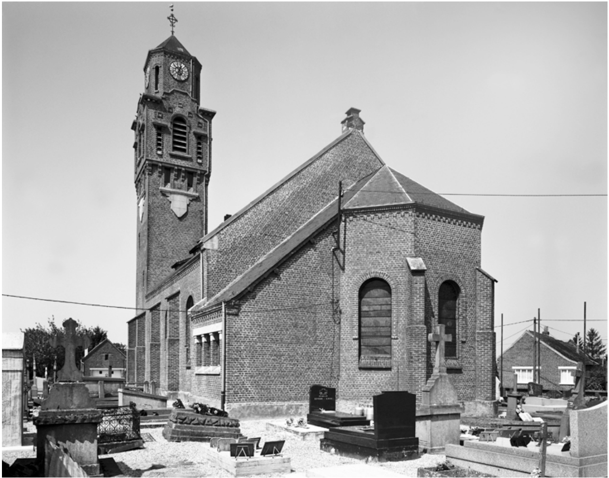
Vue générale sud-est de l'église reconstruite.
