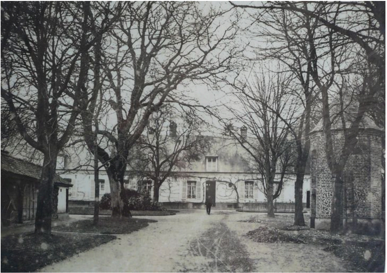
Vue de la propriété au milieu du 20e siècle, avec les étables à cochons au sud de la cour.
