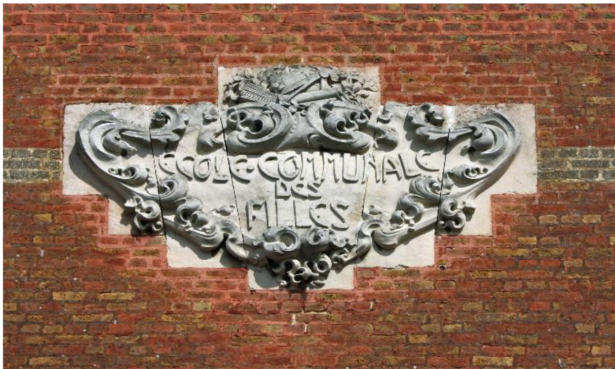
Détail du cartouche orné de l'école communale des filles.
