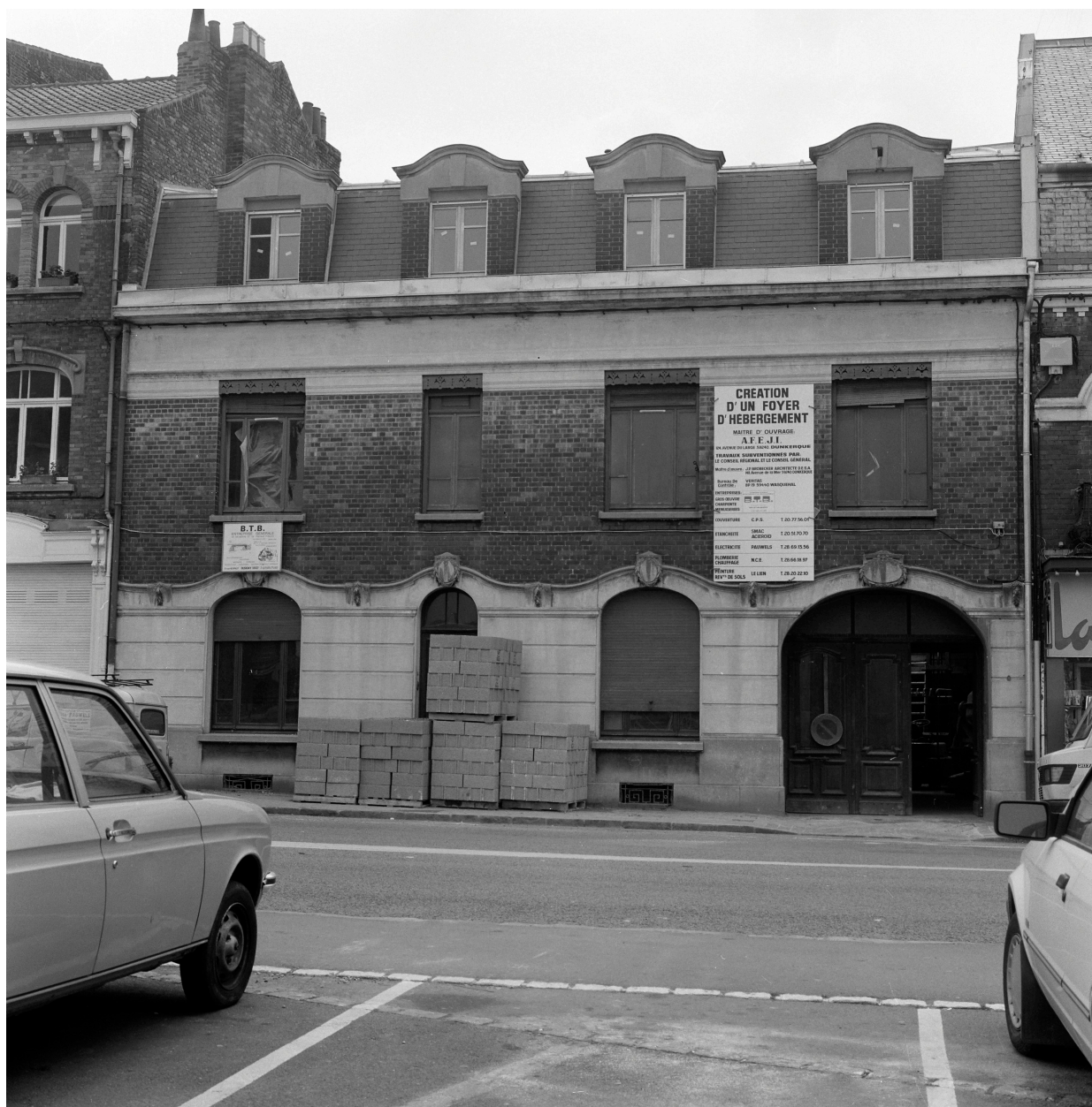
Élévation antérieure place Saint-Vaast.
