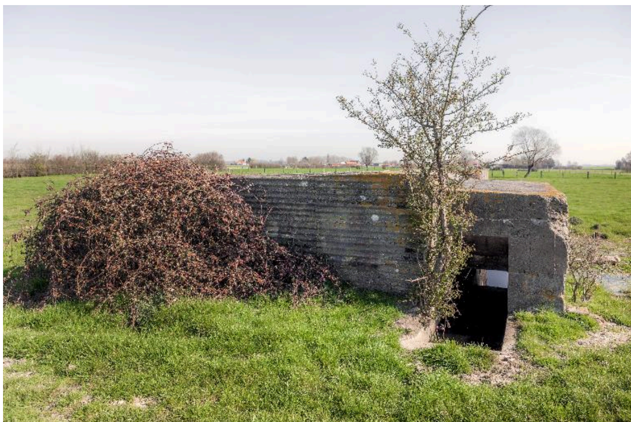
Vue latérale vers le nord-est avec le porche pare-souffle en enfilade
