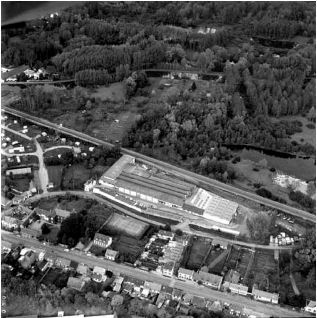
Vue aérienne, flanc sud.
