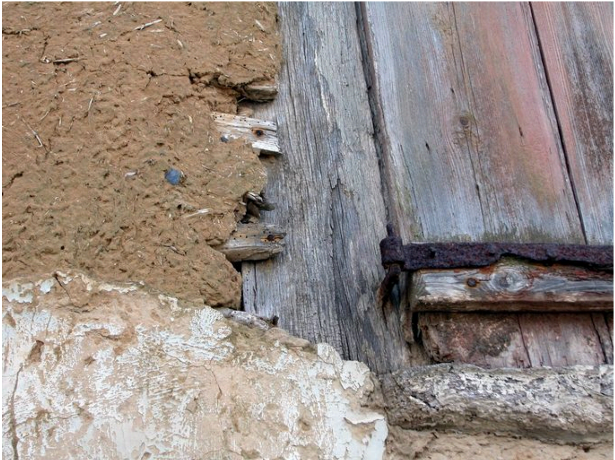
Détail des matériaux de construction.
