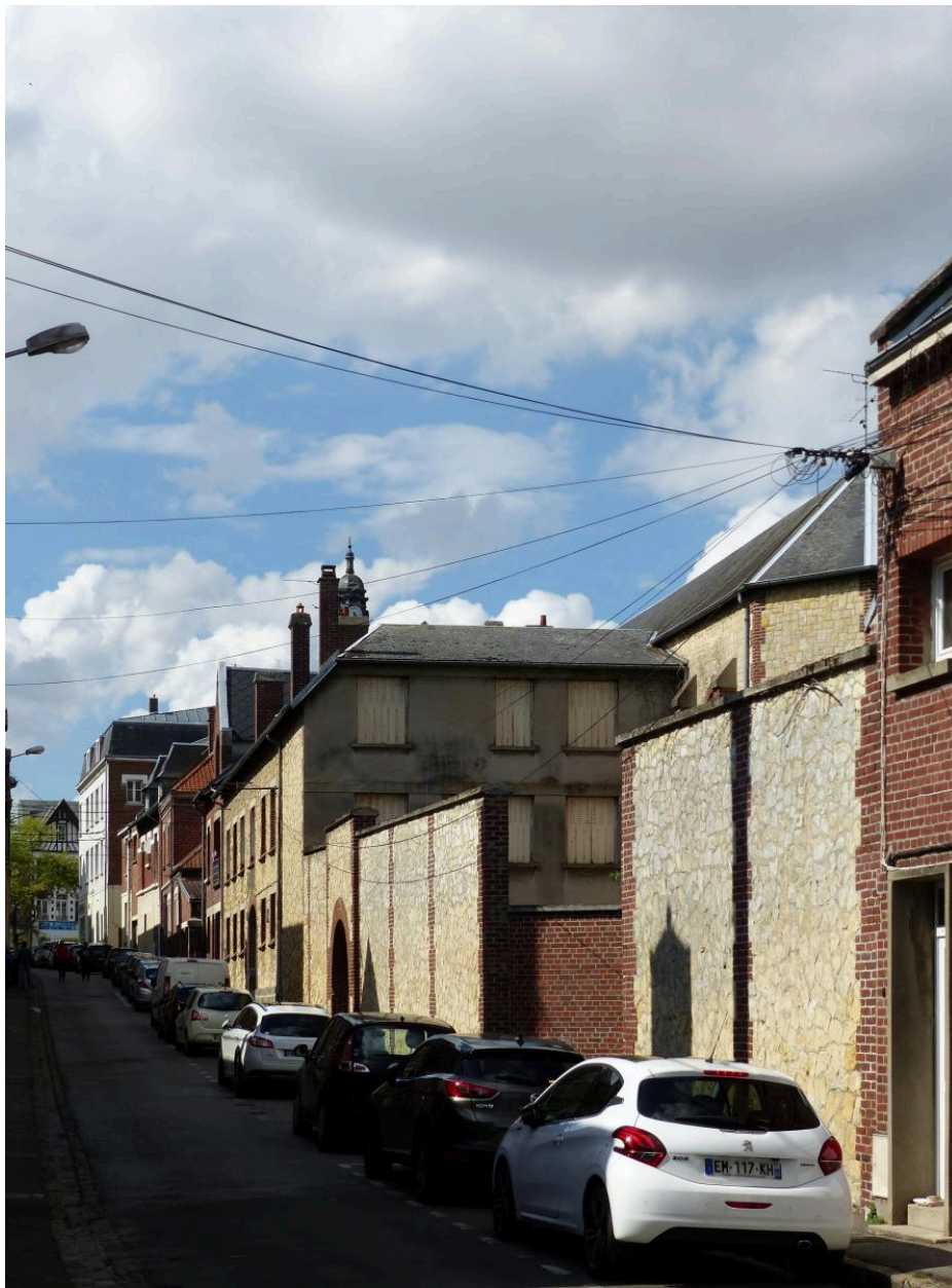
Vue de situation, depuis le bas de la rue des Naviages.
