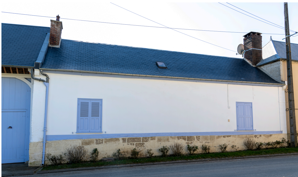
Logis sur rue d'une ancienne ferme, n°24 de la rue Principale, vue depuis le nord.
