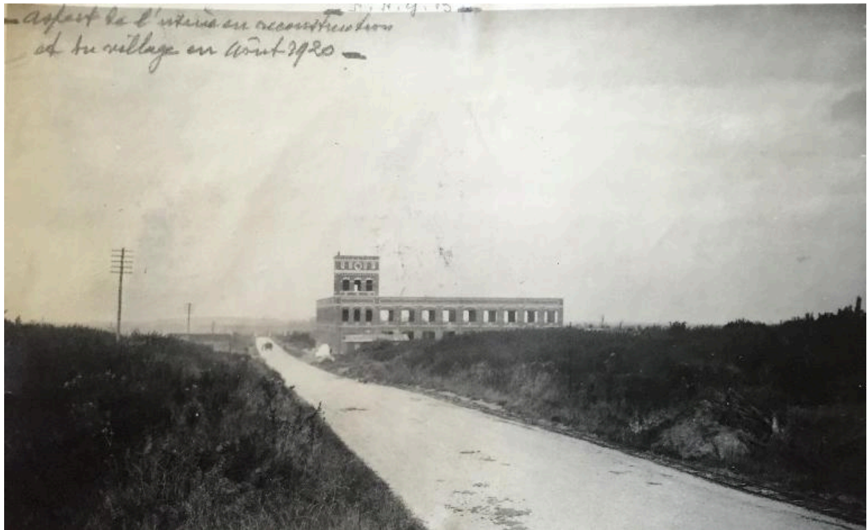
Bâtiment principal côté sud vers la route. Aspect de l'usine en reconstruction. 30 août 1920 (AD Somme ; 10 R 1062).
