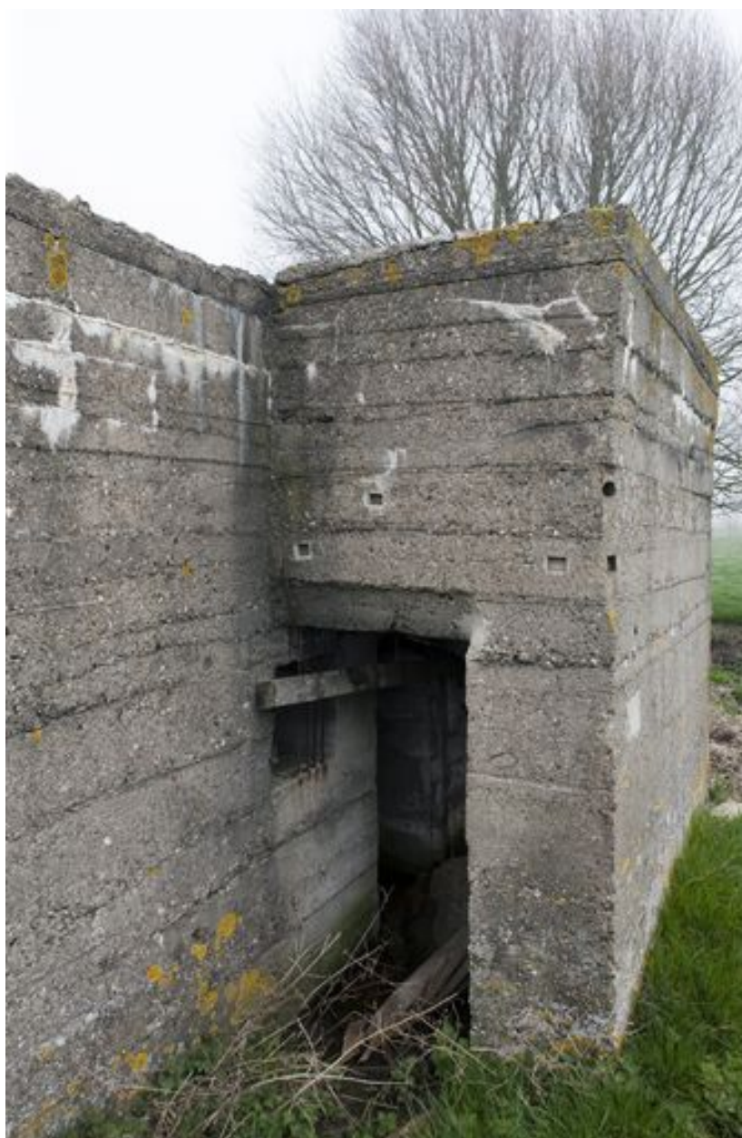
Elévation sud, porche pare-souffle
