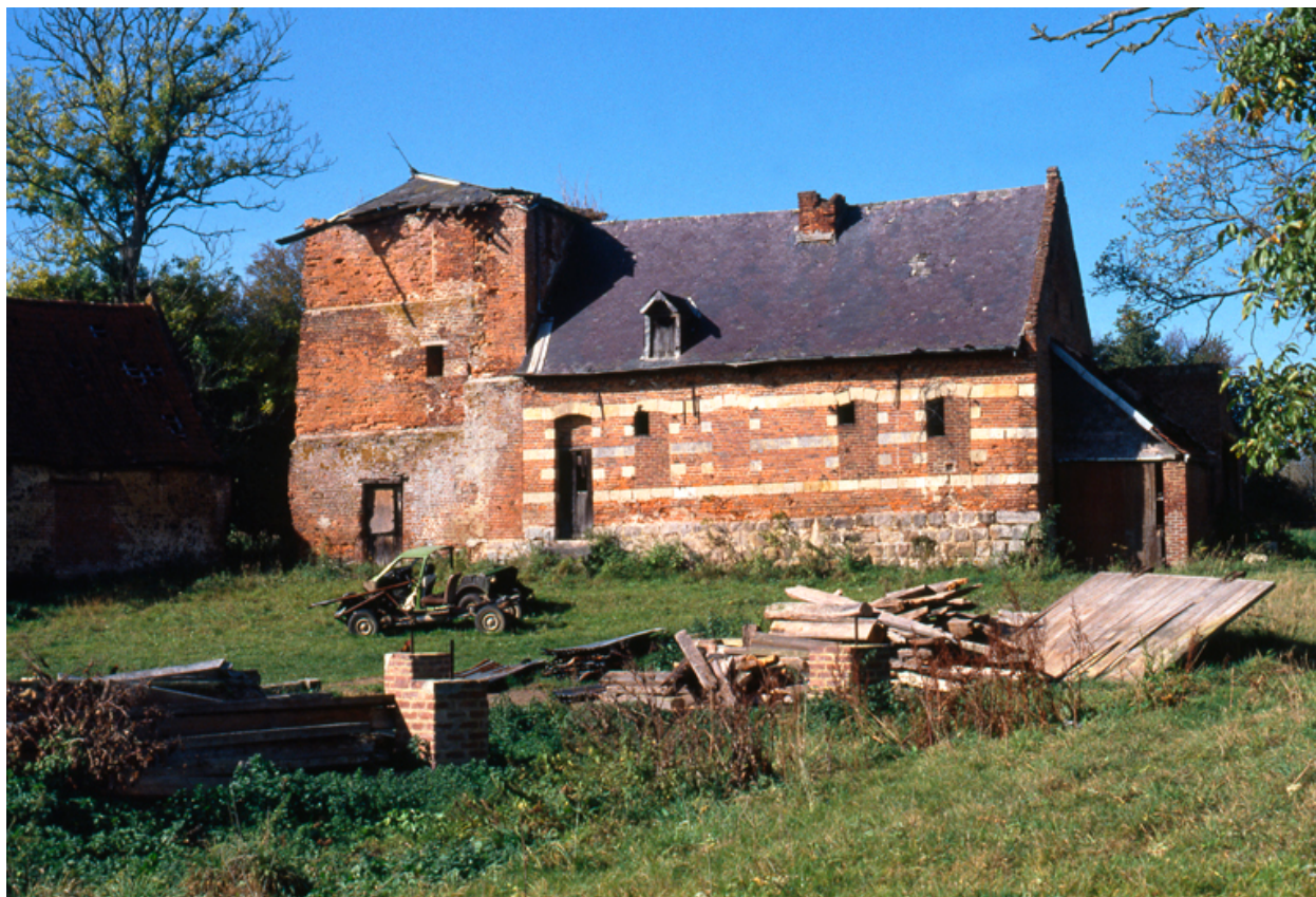
Première ferme. Vue d'un ancien logis.
