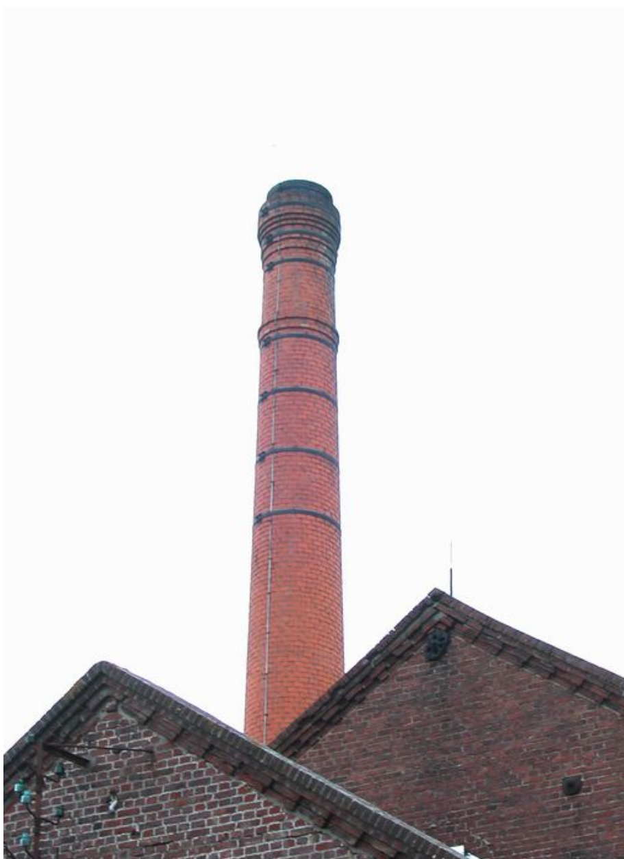
Détail des pignons des ateliers de fabrication et la cheminée de la chaufferie à l'arrière plan.
