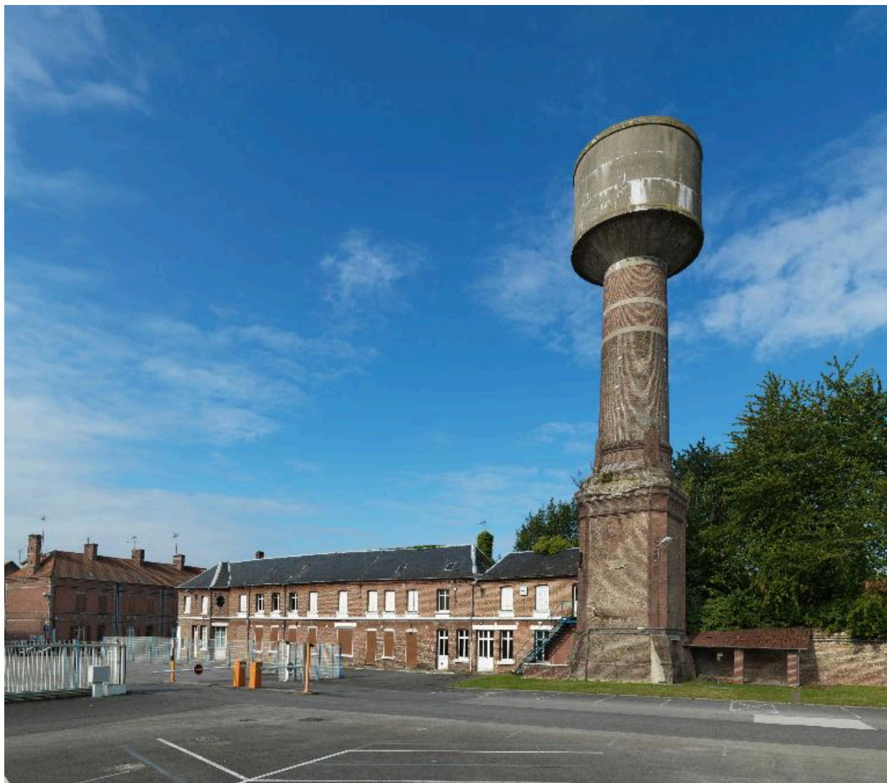
L'ancienne infirmerie et l'ancienne cheminée de 1865 attenante, vue de face.
