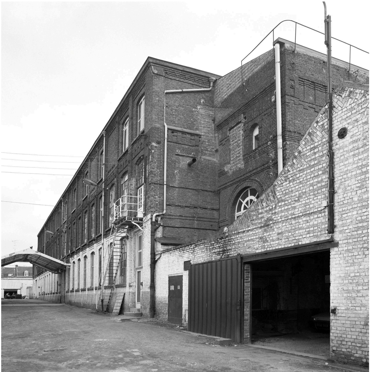
Salle des machines et atelier de fabrication.
