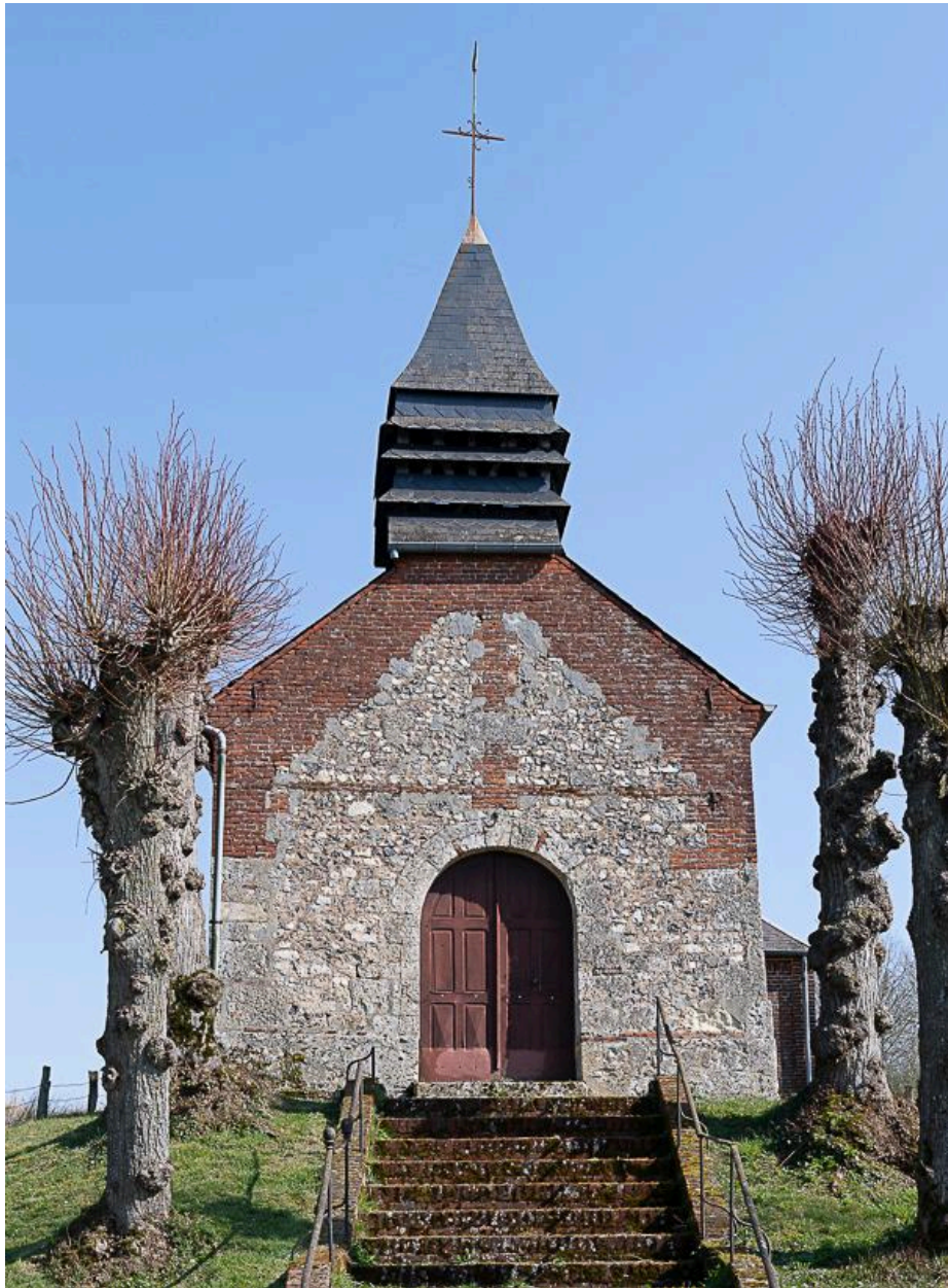
Vue de la façade occidentale.
