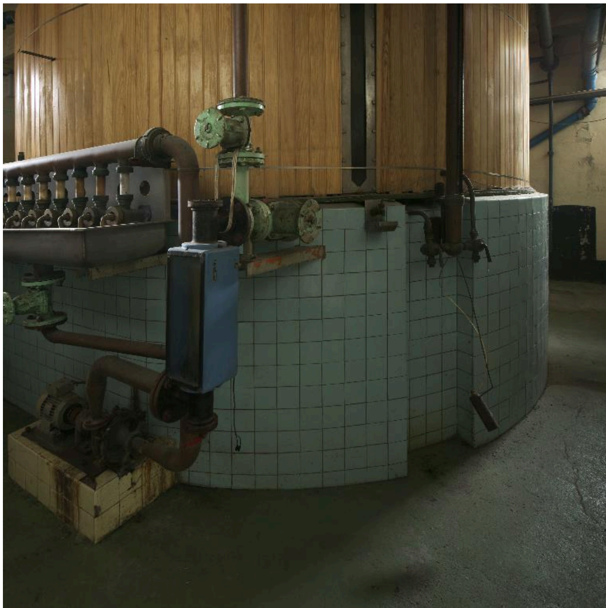
Cuve de filtration.
