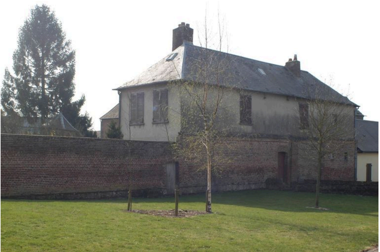
Façade postérieure ouest.
