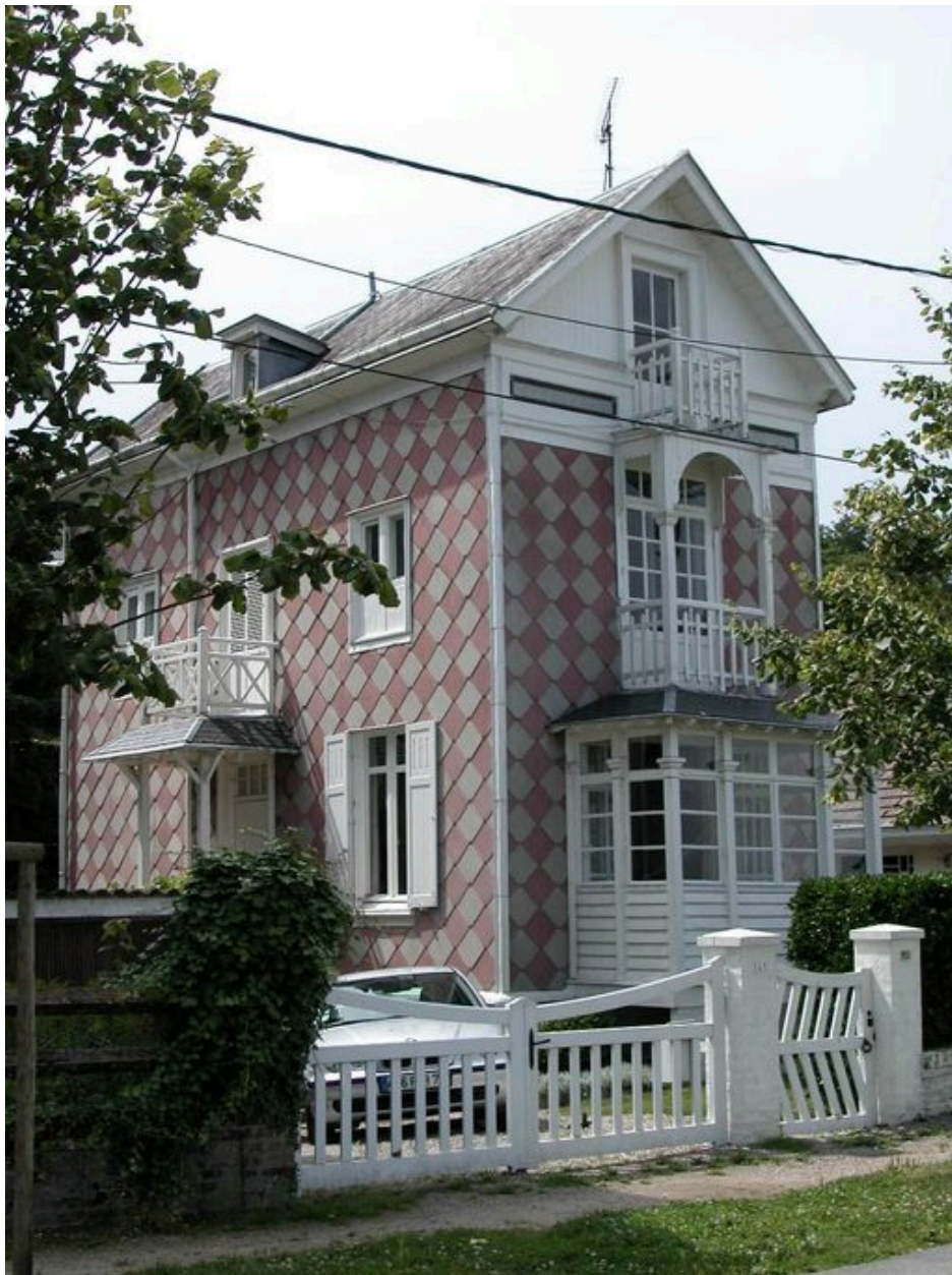
Vue d'ensemble depuis la digue.
