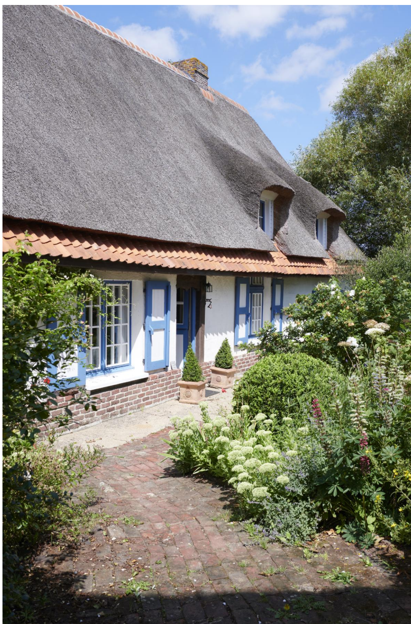
Façade sud-est. Détails.
