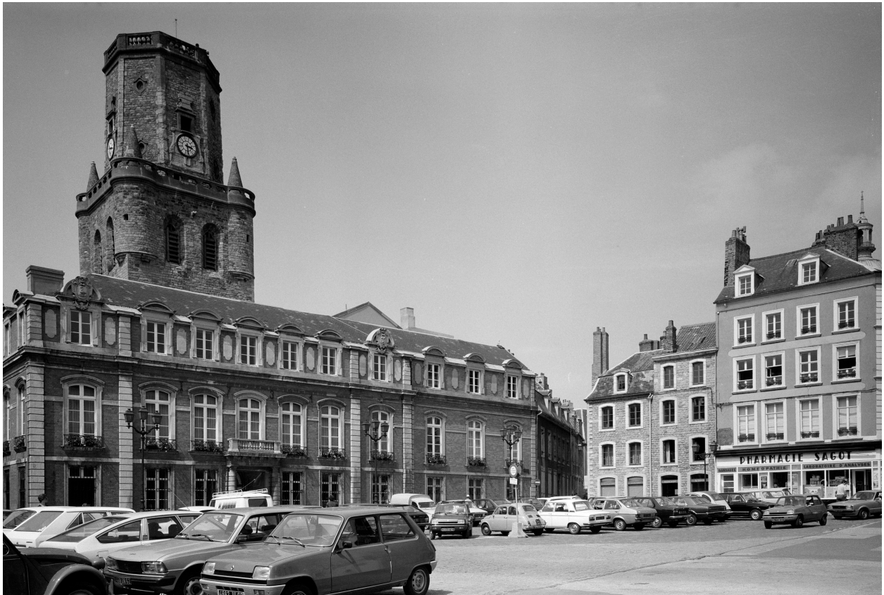
Vue générale sur place Godefroy de Bouillon.
