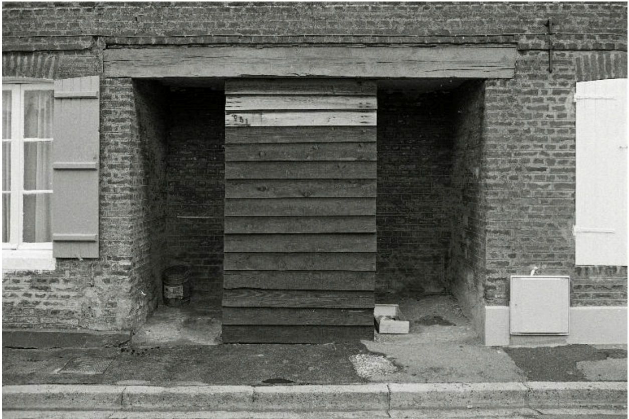
Le puits de la cité, en 1990, vue de face.
