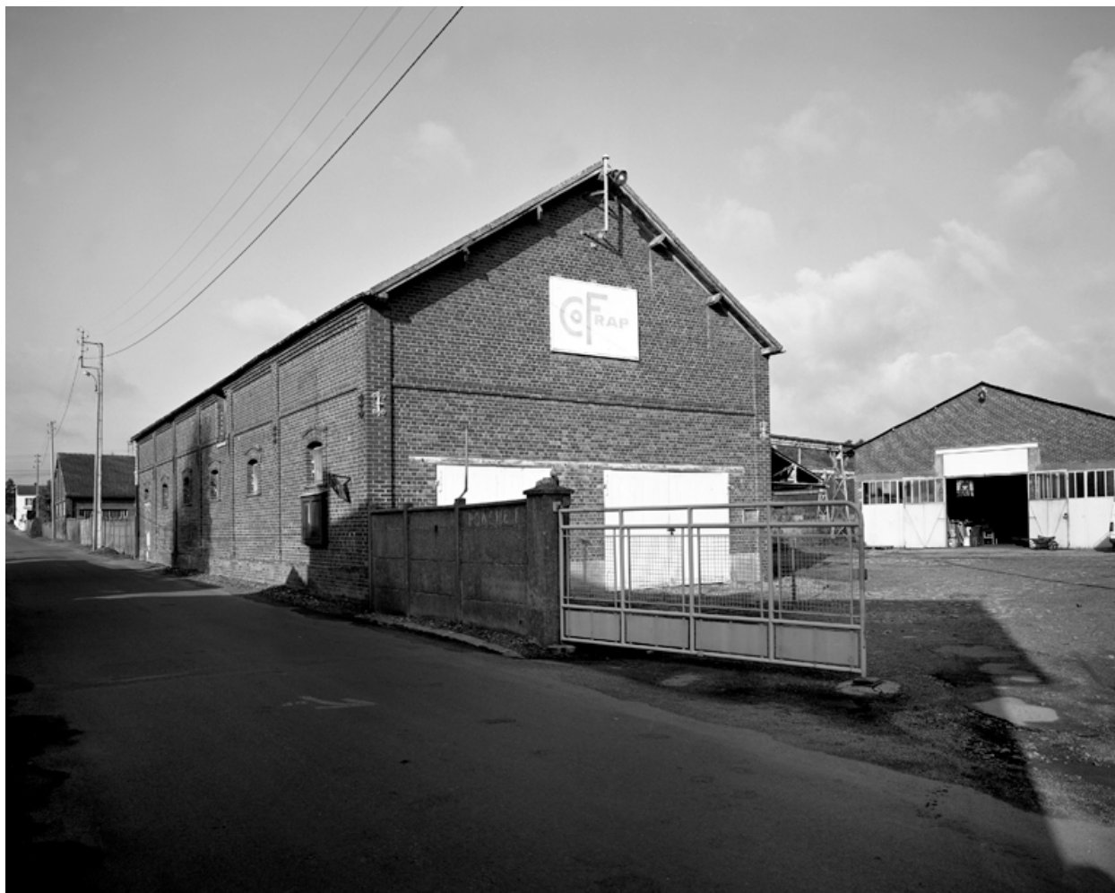
Ancienne étable à chevaux, aménagée actuellement en vestiaire, façades sud-ouest.
