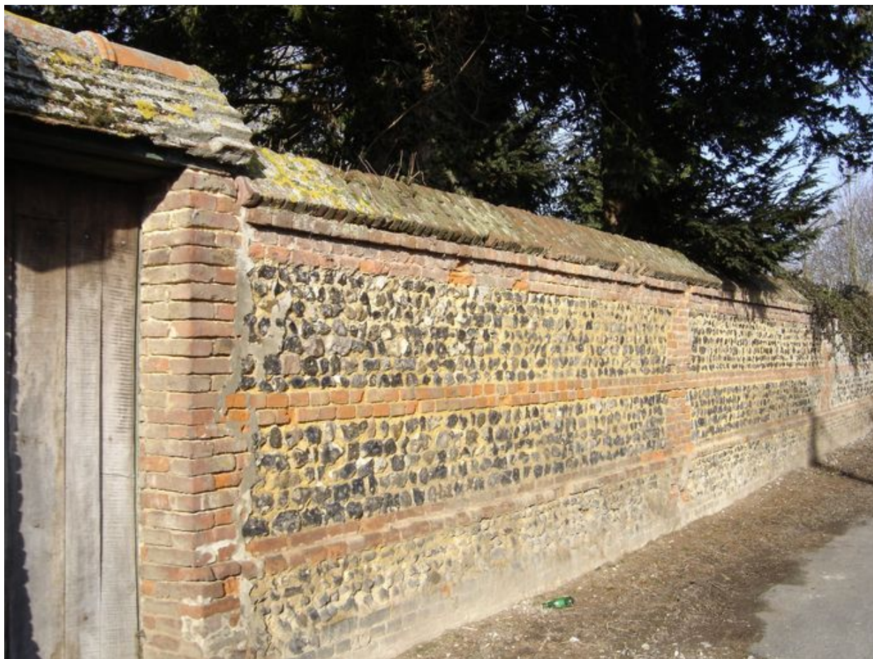
Vue du mur de clôture dans la rue Jacquot.
