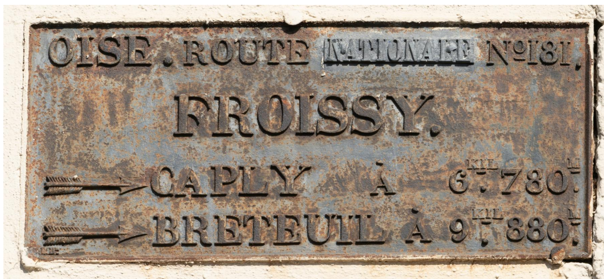
Ancien panneau signalétique, façade du n°33 rue de Provinlieu, vue depuis l'est.
