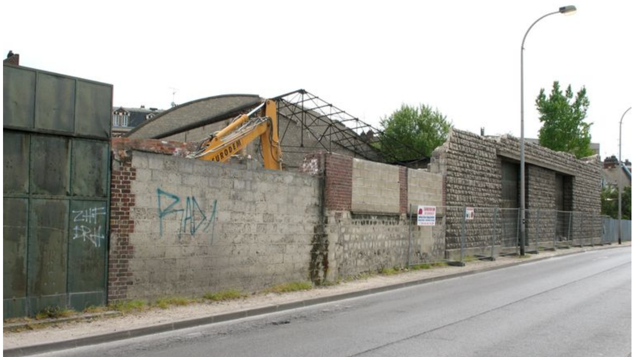
Avril 2007 : façades sur la rue Stéphenson.
