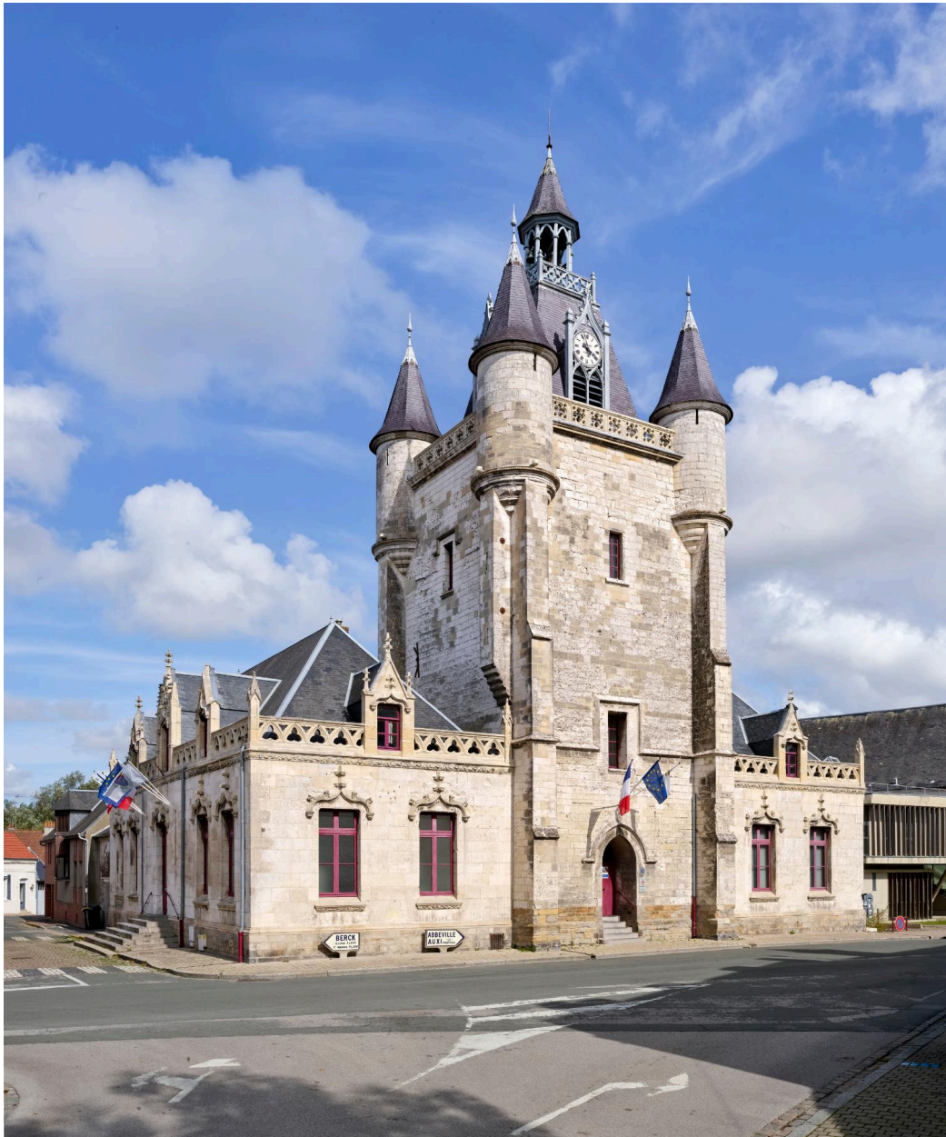
Vue d'ensemble sud-ouest du beffroi.
