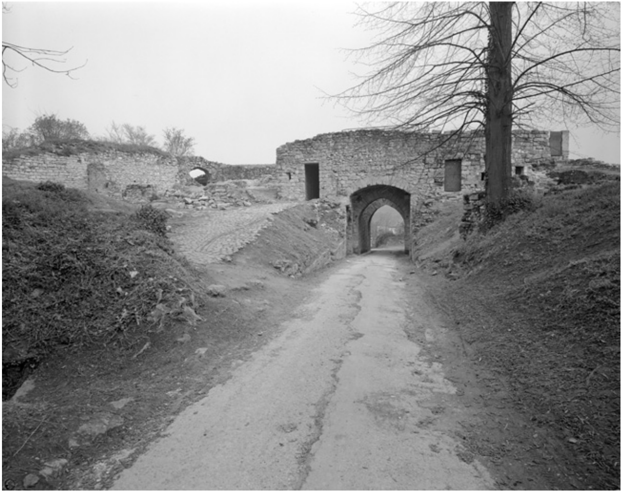
Le revers de la porte Saint-Jean, depuis l'esplanade de la basse-cour.
