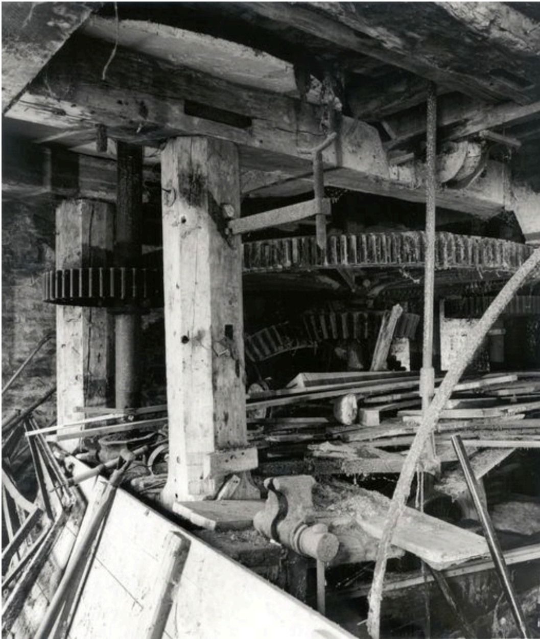
Intérieur du sous-sol surélevé, détail du beffroi et des engrenages de transmission.
