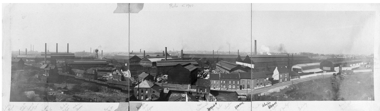
Vue panoramique de l'usine depuis l'avenue de l'Abbé-Jean-de-Beco, photographie aérienne, v.1930 (?) (coll. part.).
