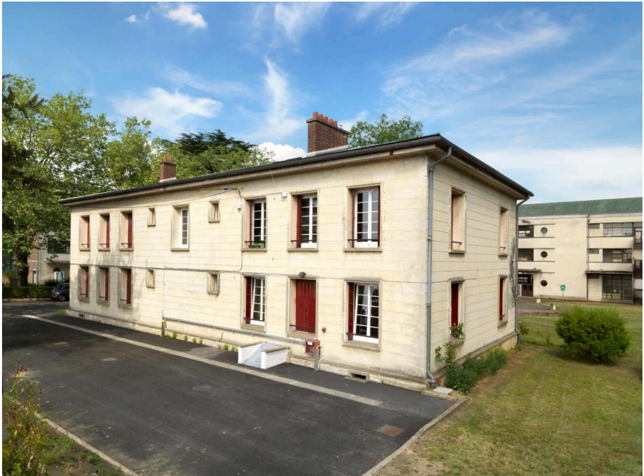
Bâtiment administratif du collège, vue de trois quarts depuis le nord-est.
