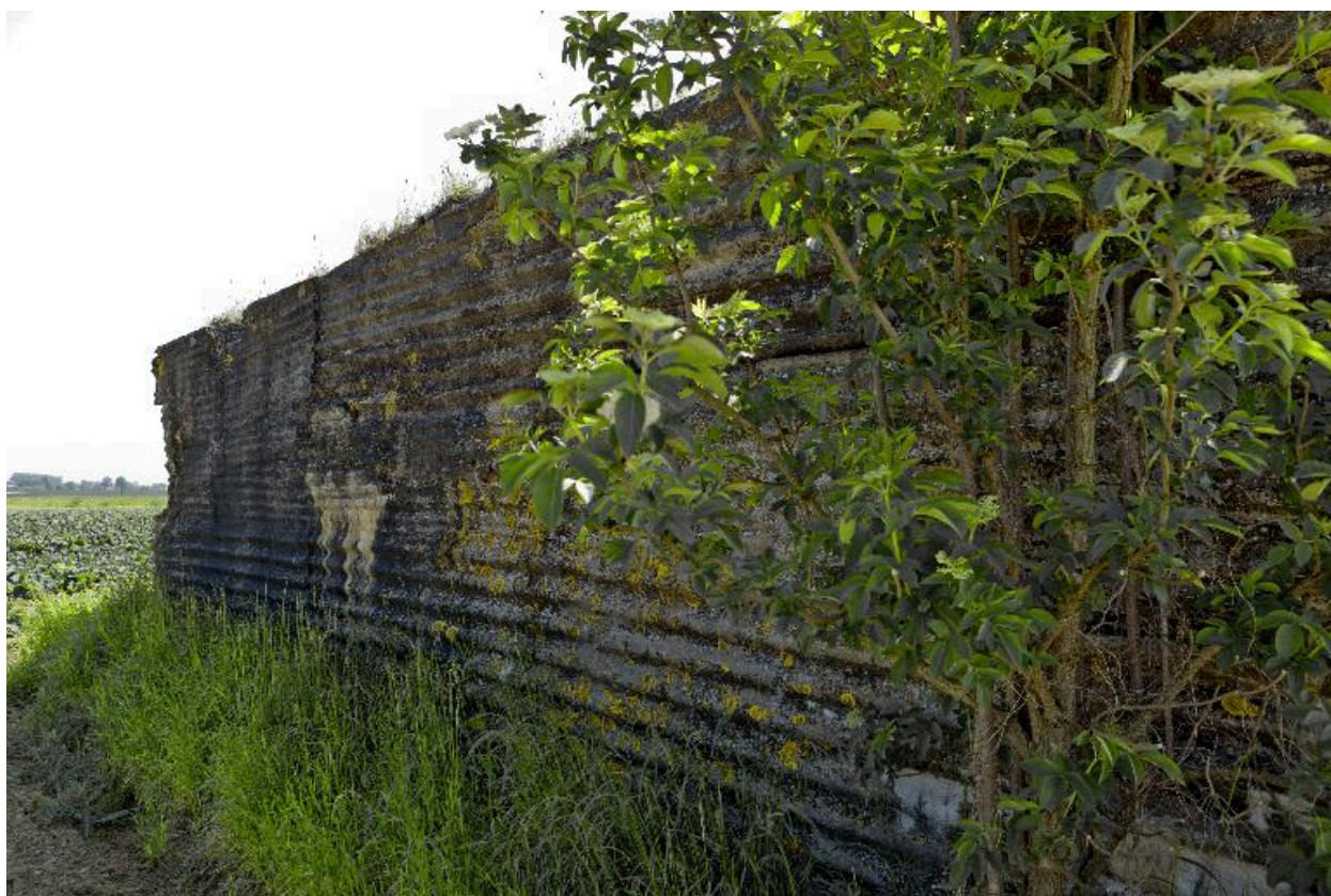
Elévation postérieure. Empreintes de coffrage
