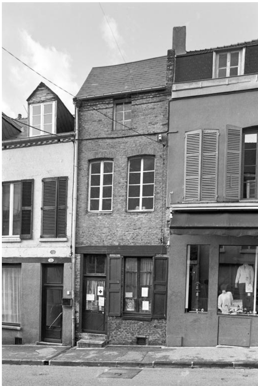
Vue de la façade principale sur rue.
