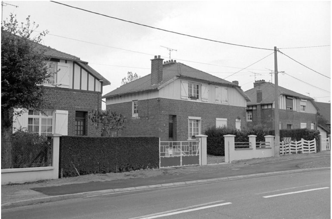
Logement d'ouvriers, vue d'ensemble.
